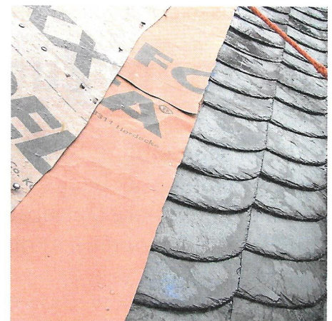
▲ Ehrensache: Das Abfangen von Niederschlägen bei Arbeitspausen durch den Schleppestreifen
