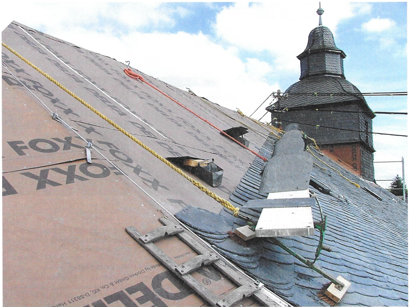
▲ Diffusionsoffene Schalungs- und Unterdeckbahnen kommen immer häufiger auch als Vordeckung – zum Beispiel unter Schiefer – zur Ausführung
