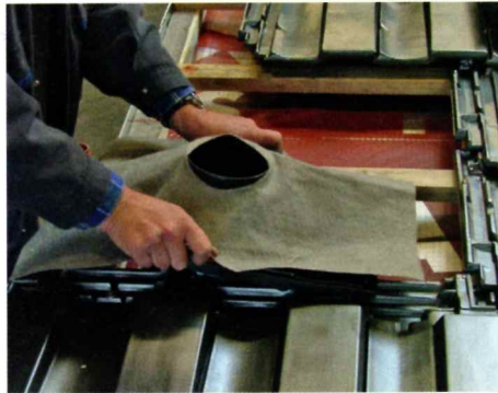
Über das Entlüftungsrohr eines Sanitär-Lüfterziegels wird eine Manschette gezogen ...
