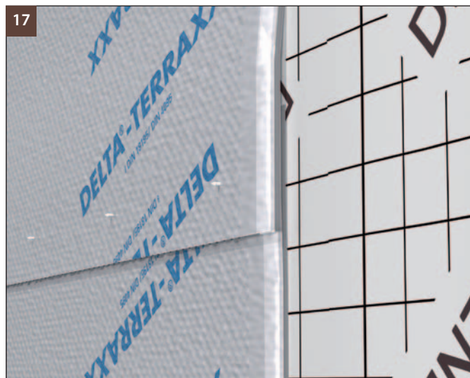
(obr. 17) Oba pásy se pak spojí pomocí min. 4 ks DELTA®-SAMOLEPICÍCH trnů.
