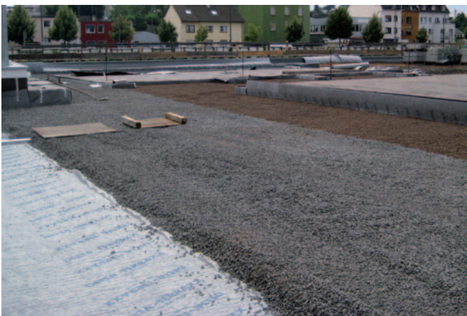
„Little Soho“, Frankfurt am Main
