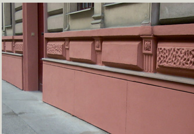
Sokl opravený pomocí DELTA®-PT.
