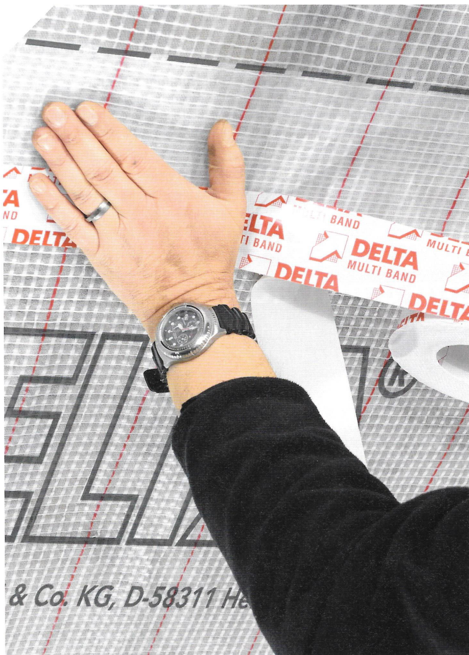
▲ Anwendungsfall nach DIN 4108-11: Die luftdichte Verklebung von flexiblen Luftdichtheitschichten
