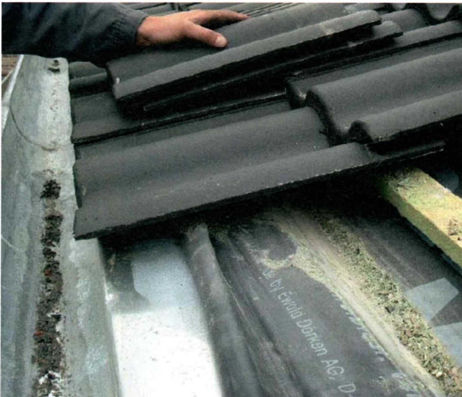
Bei eingeschnitter Regenrinne ist die Unterlüftung des Deckmaterials nicht mehr gegeben
