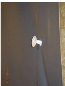
Vissage de DELTA®-QUICKFIXX au travers du pare-pluie dans l'isolant
