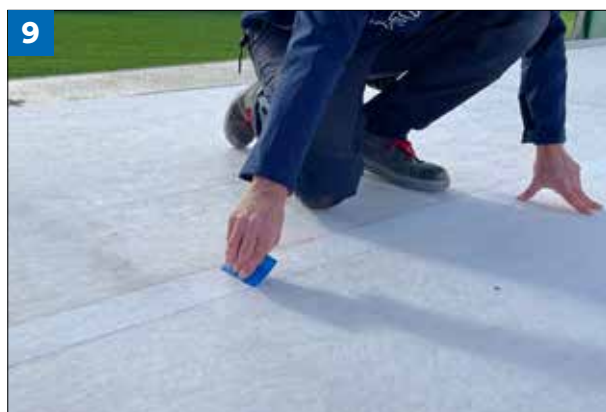
(Figure 9) La finalisation du collage du recouvrement à l'aide d'une marouffette est recommandée. Celle-ci permettra d'assurer un collage uniforme etc sans cloques.
