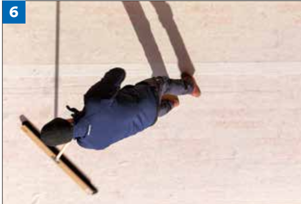
(Figure 6) A l'aide d'un large balai, d'une raclette ou d'un instrument similaire, appliquer une pression sur la zone FP 1 de la membrane en repoussant les éventuelles poches d'air vers son bord.
