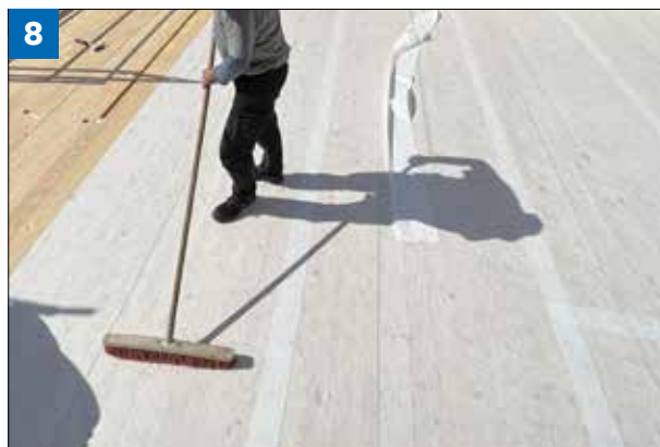
(Figure 8) A l'aide d'un large balai ou d'une raclette, appliquer une pression sur la zone FP2 de la membrane en repoussant les éventuelles poches d'air vers son bord.
