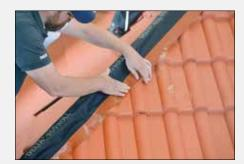
Modellare e adattare le bande laterali dei sottocolmi DELTA® nel modo più uniforme possibile sulla copertura. Devono essere evitate le tensioni di trazione che agiscono sull'incollaggio. Evitare un «eccessivo stiramento» delle bande in direzione trasversale al rotolo.
