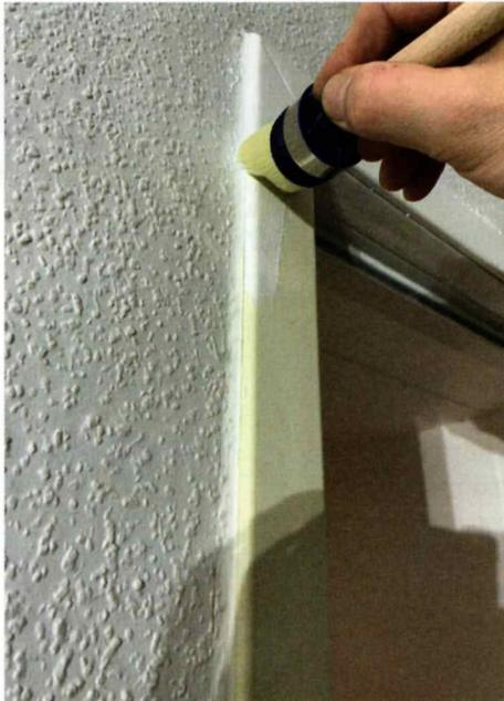
Decklackierung der Zarge mit dem Pinsel. Für die Fläche nimmt man die PU-Schaumwalze
