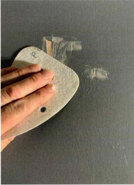
Zunächst werden Beschädigungen gespachtelt und die Fläche mit Schleifpapier angeschliffen
