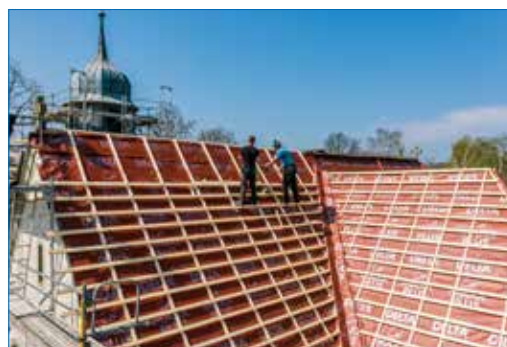
Rys. 5: Różne membrany wstępnego krycia podczas oddziaływania warunków atmosferycznych.
