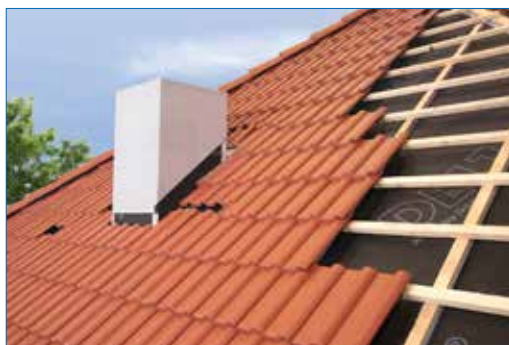
Rys. 6: Przy dachu pokrytym membrana wstępnego krycia jest chroniona przed promieniowaniem UV, ale nie przed ciepłem i ruchami powietrza w przestrzeni między pokryciem a membraną.
