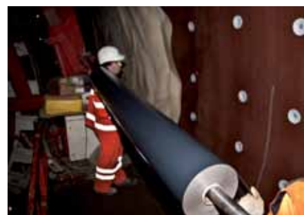
Монтаж гидроизоляционной мембраны.
