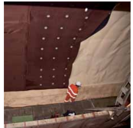
Установка гидроизоляционного слоя.
