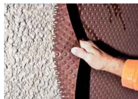
Дренажная мембрана на торкретбетоне.
