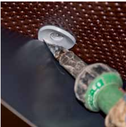
Сварка гидроизоляции с ронделем.
