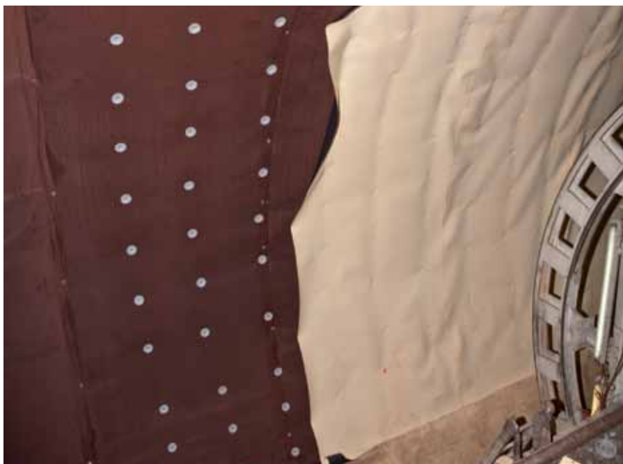
Дополнительное крепление ронделей, на которые потом будет приварена гидроизоляционная мембрана.
