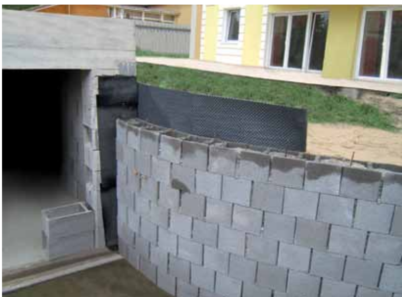
DELTA®-TERRAXX обеспечивает стабильность подпорной стены.
