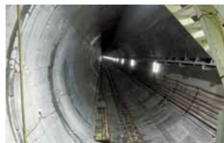
Протечки тьюбингов без применения дренажной мембраны.
