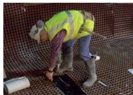
Проклейка нахлёстов лентой DELTA®-THENE BAND T 300.
