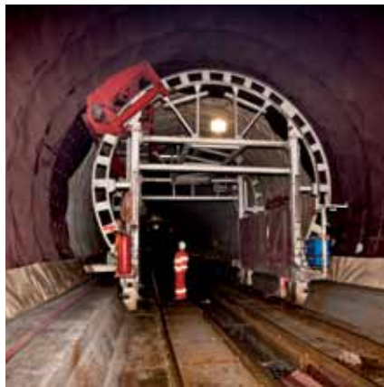
Крепление рулонов с подвижной платформы.
