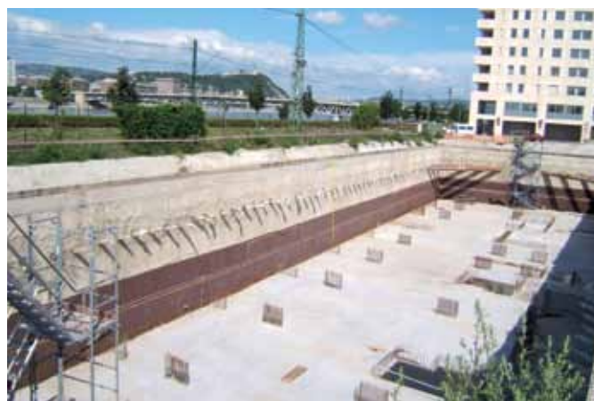
Пример: строительство подземного комплекса около р. Дунай.
