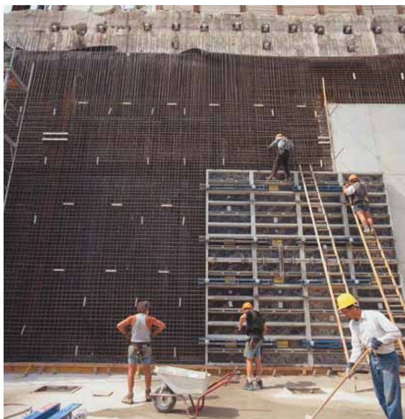
DELTA®-MS 20, строительство станции метро в Дуйсбурге
