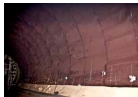
Изначально мембрана крепится только в зоне нахлёста.
