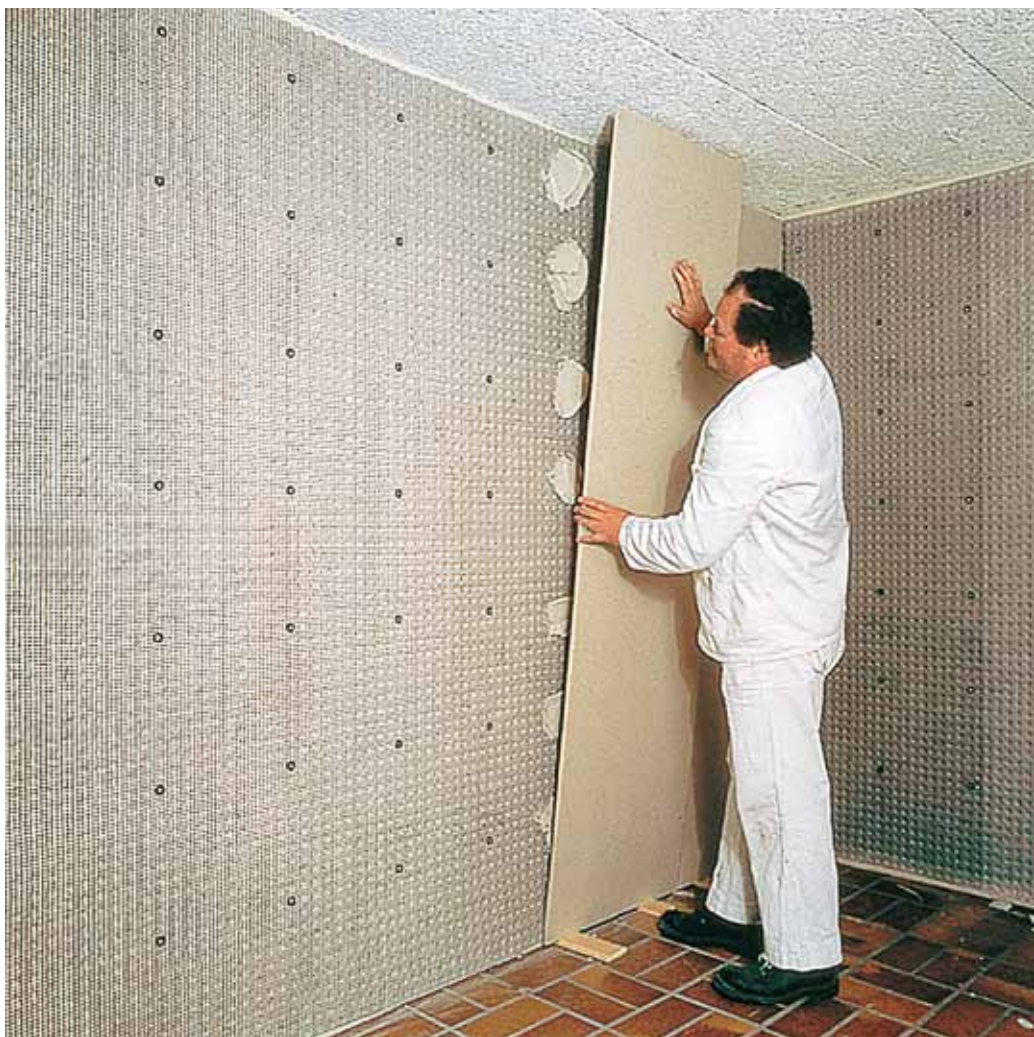
DELTA®-PT образует водонепроницаемое устойчивое основание для гипсовой и известково-цементной штукатурки или гипсокартонных листов.
