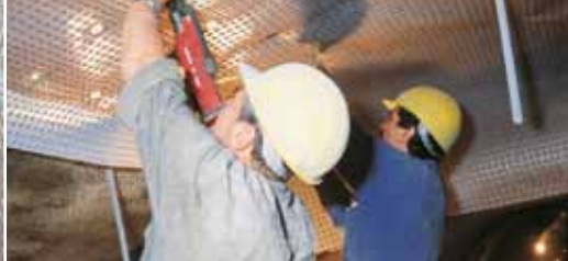
В тоннеле DELTA®-PT служит несущим основанием для торкретбетона.
