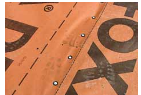
Допустимое открытое крепление гвоздями с уплотнением
