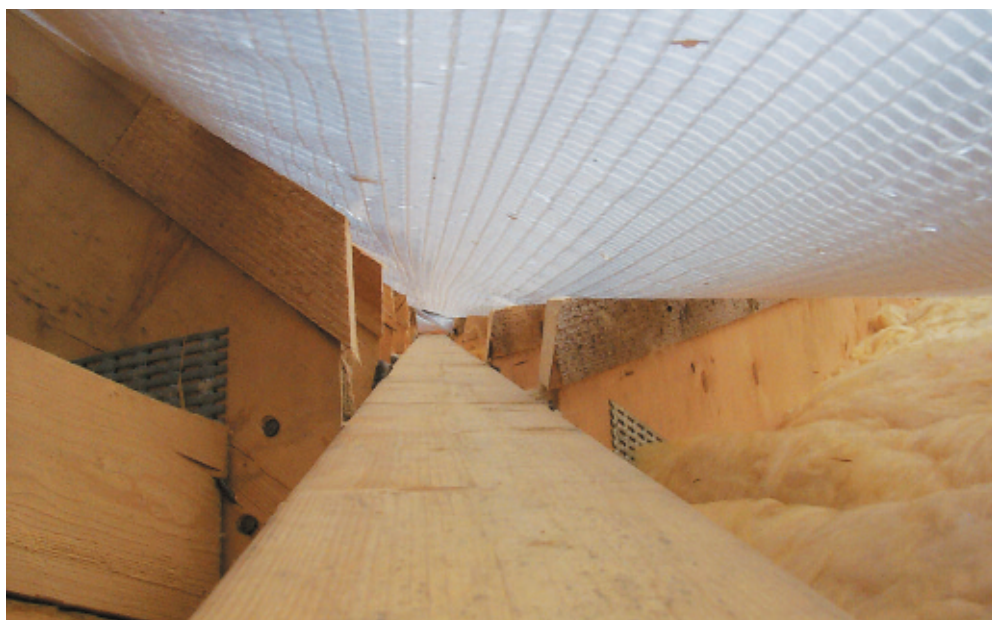
Рис 3. Организация продольной вентиляции на крыше с микроперфорированной плёнкой. Желобок ендовы монтируется на учащённую обрешётку. Достаточный провис плёнки обеспечивает сток конденсата (фото автора).
