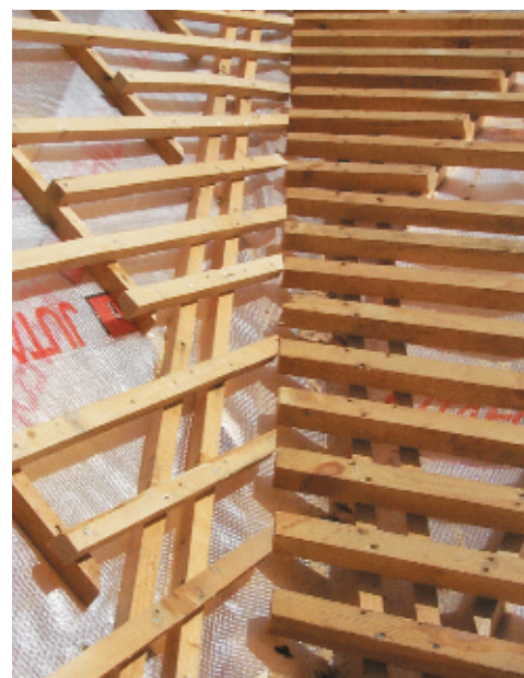
Рис 3. Организация продольной вентиляции на крыше с микроперфорированной плёнкой. Желобок ендовы монтируется на учащённую обрешётку. Достаточный провис плёнки обеспечивает сток конденсата (фото автора).
