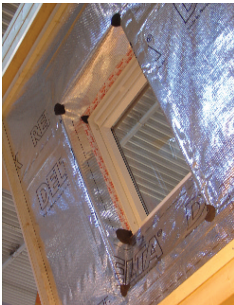
Рис. 10 Дополнительная проклейка углов проемов мансардных окон
