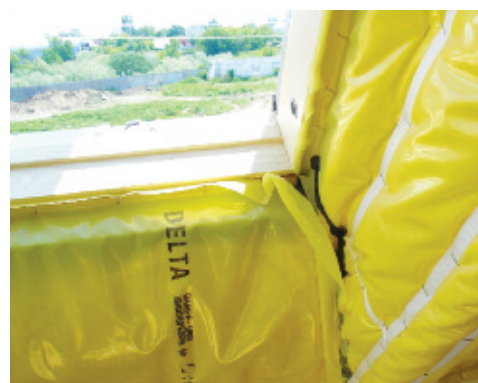
Рис.8 Ошибки при устройстве пароизоляции окна, негерметичное примыкание пленки к коробке
