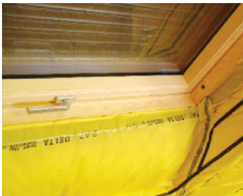
Рис.8 Ошибки при устройстве пароизоляции окна, негерметичное примыкание пленки к коробке
