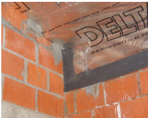
Рис.7 Герметичная проклейка пароизоляции специальной уплотнительной лентой
