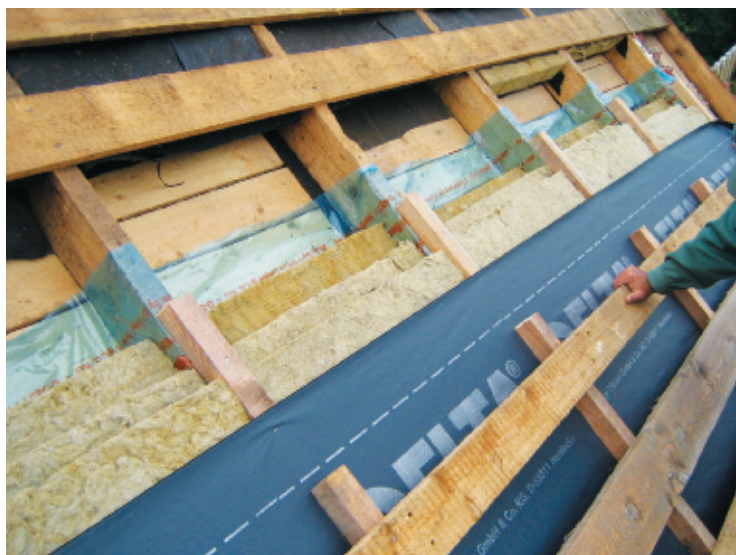
Рис. 7. Укладка диффузионной мембраны
