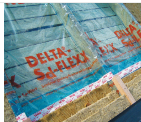
Рис. 4. Проклейка нахлестов пароизоляции односторонней лентой
