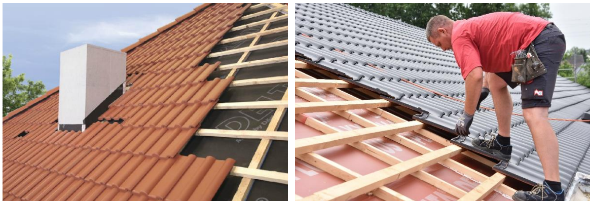
Рис. 6: в закрытом состоянии мембрана защищена от УФ-излучения, но не от тепла и движения воздуха в пространстве между покрытием и мембраной.
