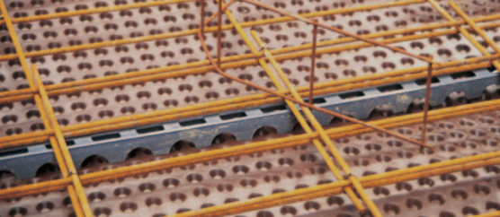
Uloženie plastových dištančných podložiek pod armatúru.
