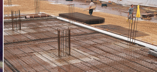
Spoločiteľná náhrada podkladového betónu pod základovú dosku.
