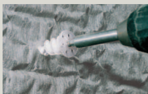
DELTA®-TERRAXX-SKRUTKA Spolahlivé kotvenie fólie DELTA®-TERRAXX na perimetrické dosky. Chránené patentom.
