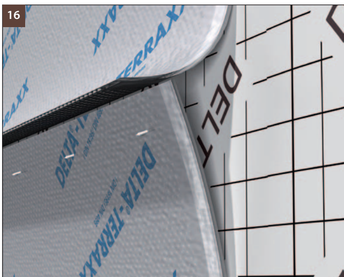
(obr. 16) Pokiaľ je nutné zvisle pokladané pásy nadstaviť, podsunie sa spodný pás o min. 20 cm.
