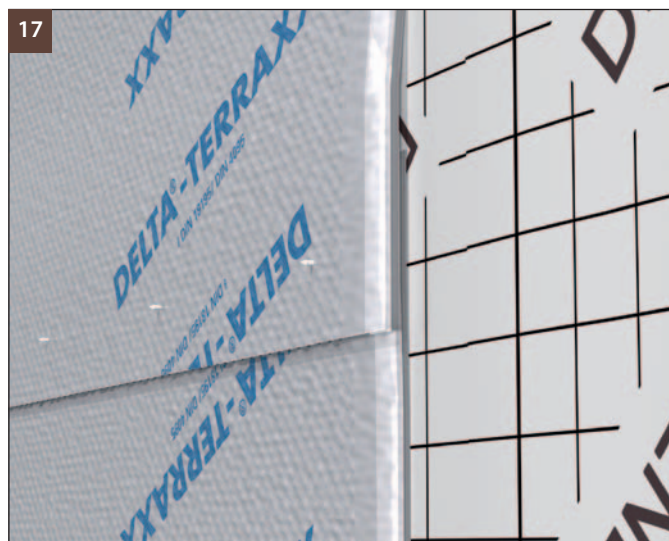
(obr. 17) Oba pásy sa následne spoja pomocou min. 4 ks DELTA®-SAMOLEPIACICH TRŇNOV.
