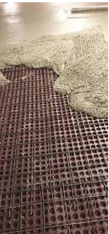
**DELTA®-MS 20, tünel tabanı, temel altı, endüstriyel zeminler ve bodrum katlarının zeminlerinde yükselen suya karşı koruma sağlarken üzerine dökülen betonun sağlıklı prizlenmesini ve dolayısıyla mukavemetini korumasını sağlar.**
