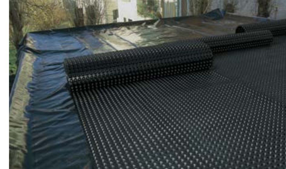
Taşıması, depolaması, döşemesi kolay, hızlı ve ekonomik drenaj levhası.
