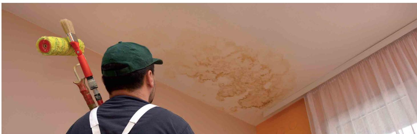
Isoler et bloquer les fonds consiste à empêcher de manière durable et efficace toutes remontées de substances, de traces, de taches à travers le film de peinture. De par sa composition spécifique à base de résine synthétique acrylique, la peinture KERIAFIX ISOL bloque et empêche la migration des substances, des traces et des taches, et peut être recouverte après 30 minutes par tous types de peintures de finition en phase aqueuse ou en phase solvant.
