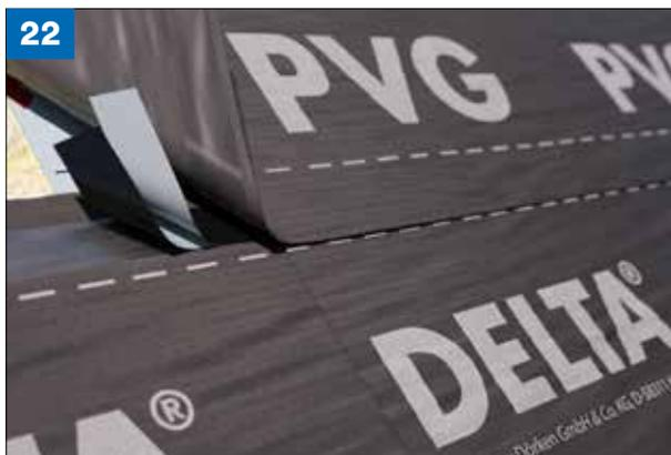
**(Bild 22)** Nach Befestigung der Bahnen diese luftdicht verkleben. Bei DELTA®-PVG PLUS mit dem Selbstkleberand, bei anderen DELTA®-Luft- und Dampfsperren/-bremsen alternativ mit DELTA-MULTI-BAND®.
