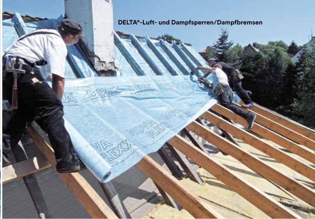
DELTA®-Luft- und Dampfsperren/Dampfbremsen
