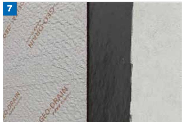
**(Bild 4 und 5)** Seitliche Überdeckung: Die Bahnen werden seitlich auf dem glatten Bahnenrand überdeckt und mit Hilfe des Selbstkleberandes dort verklebt. Bei der Verlegung darauf achten, dass die Gleitschicht der überdeckenden Bahn zuvor hinter den glatten Bahnenrand der unterdeckenden Bahn geführt wird.
