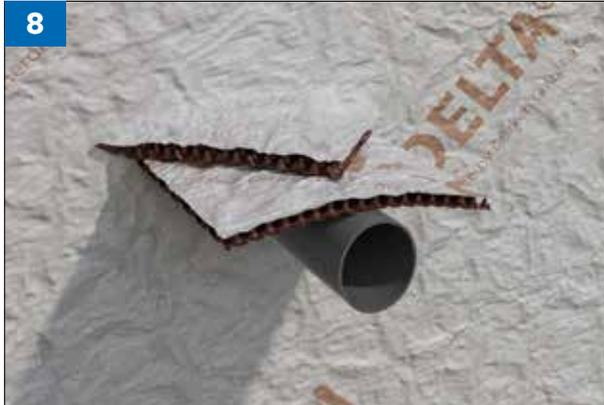
**(Bild 8)** Bei einer Kabel- oder Rohrdurchführung DELTA®-GEO DRAIN QUATTRO V-förmig einschneiden und ein ca. 30 × 30 cm grosses Reststück in die Öffnung einschieben und die Durchführung abdecken. Bei der späteren Verfüllung dann zusätzlich Kies um das Detail anlegen, um das anfallende Wasser dort schneller abzuführen.
