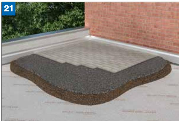
**(Bild 21)** Bei befahrbaren Flächen werden die Tragschicht und die Bettungsschicht direkt auf der verlegten Drainagebahn aufgebracht, anschliessend wird der befahrbare Oberbelag fertig gestellt.
