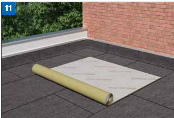
**(Bild 11)** An aufgehenden Bauteilen wird die DELTA®-GEO DRAIN QUATTRO in der Regel bis zur Oberkante des fertigen Belages hochgeführt. Wichtig: Nach Fertigstellung des Belags bzw. der Begrünung usw. ist DELTA®-GEO DRAIN QUATTRO im Randbereich abzudecken, z. B. durch Bleche (s. h. Bilder 17, 18, 19, 20)
