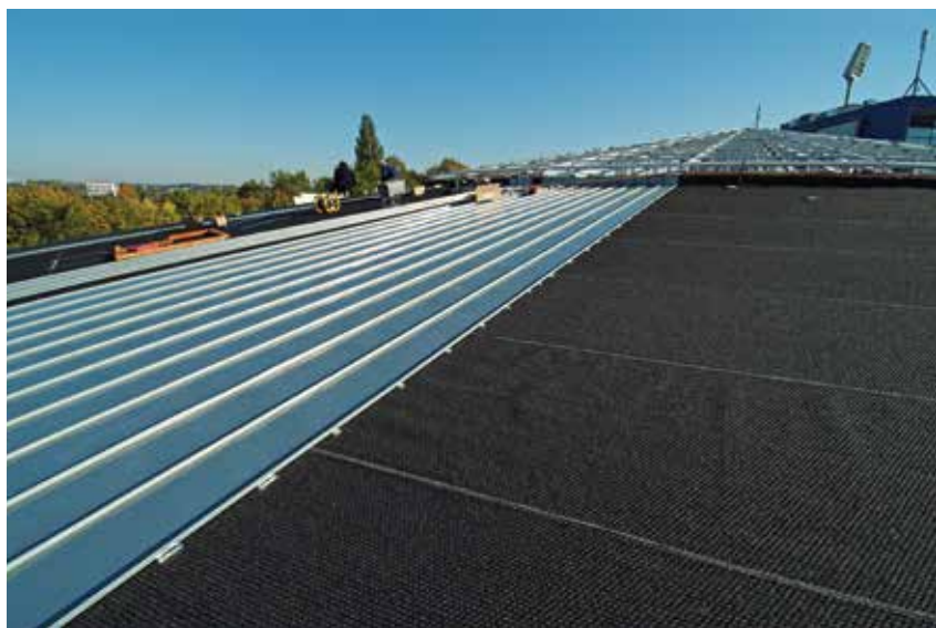
DELTA®-TRELA PLUS als Trennlage bei Metalldeckung.
