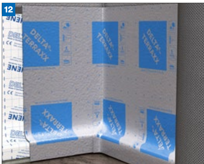
(obr. 12) Při výšce izolované stěny do max. 2,3 m se doporučuje suterénní stěnu pásem vodorovně „obalit“ a mechanicky pás fixovat v horním plochém okraji. To ušetří 50 % času na pokládku.
