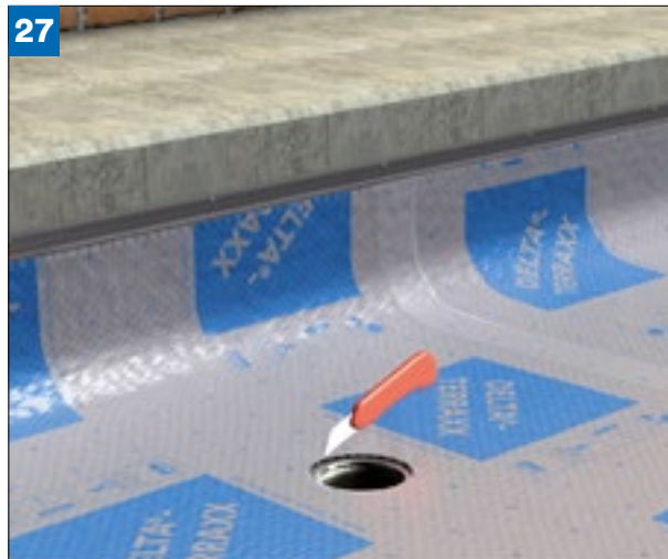
(obr. 27 a 28) Otvory pro střešní vpusti opatrně vyříznout odlamovacím nožem. Hydroizolace se přitom nesmí poškodit. Následně zamontovat střešní vpust.
