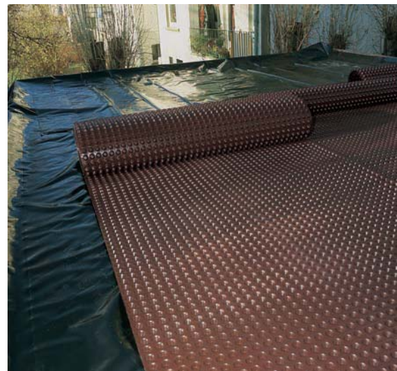
DELTA®-MS 20 perforiert dient als Wasserspeicher und leitet überschüssiges Wasser ab.
