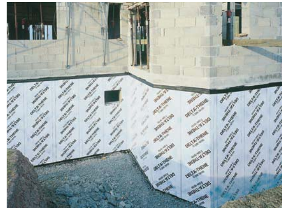
DELTA ® -THENE ist eine hervorragende Dampfsperre.
