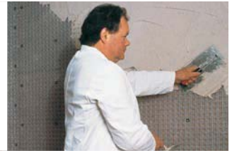
Putz einfach mit der Kelle aufziehen.
