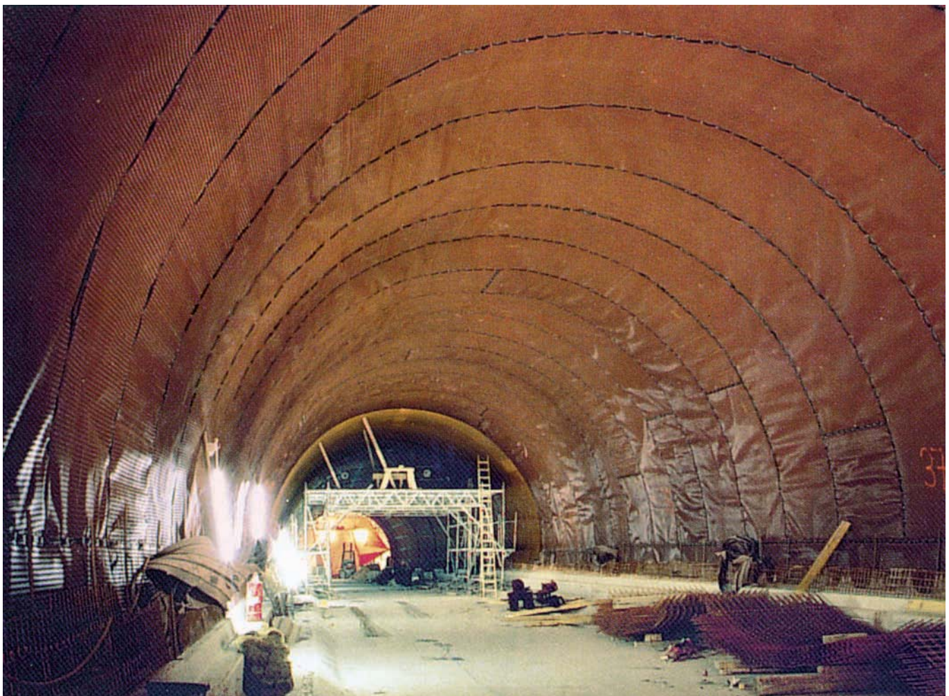
DELTA®-MS 20 besitzt eine große Drainagekapazität und bietet damit eine hohe Sicherheit.
