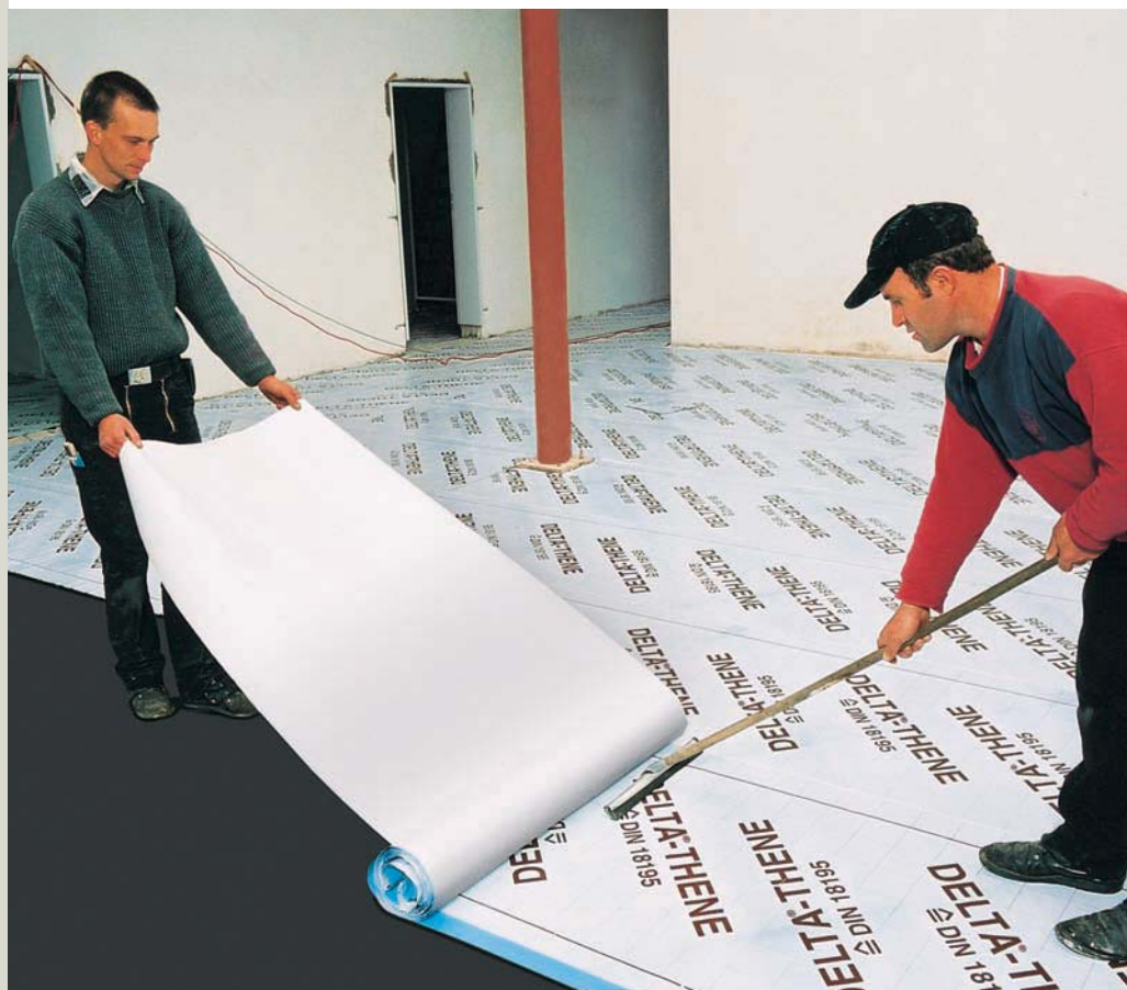
Große Flächen können mit DELTA ® -THENE ganz einfach und schnell abgedichtet werden.
