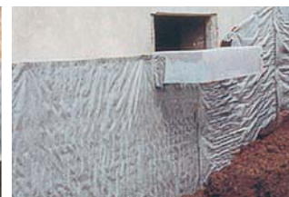
DELTA®-DRAIN hält die Grundmauer trocken und wirkt als zusätzliche Wärmedämmung.
