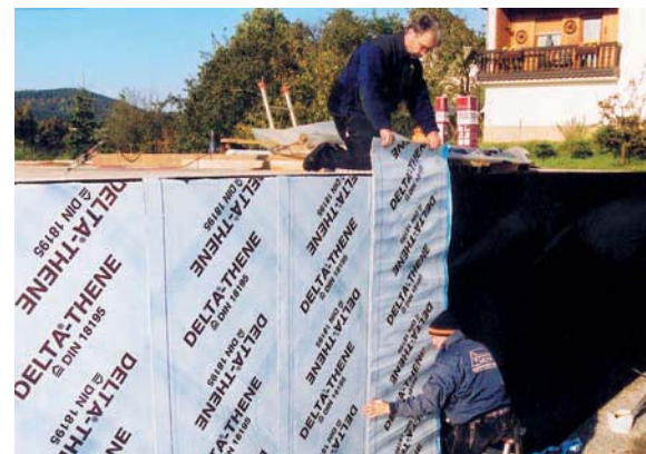
DELTA®-THENE kann einfach „tapeziert“ werden.
